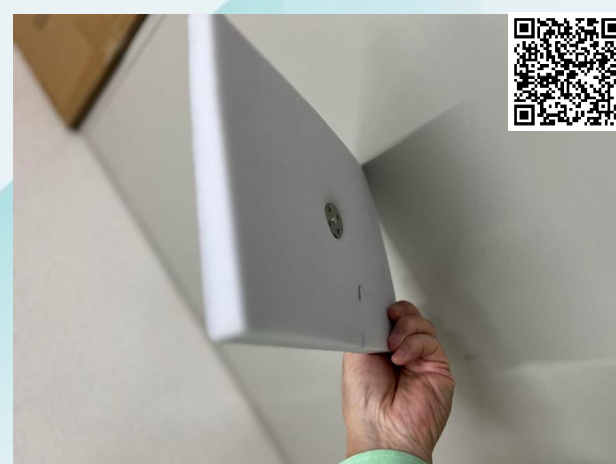
ベタッと！あっという間に設置完了
